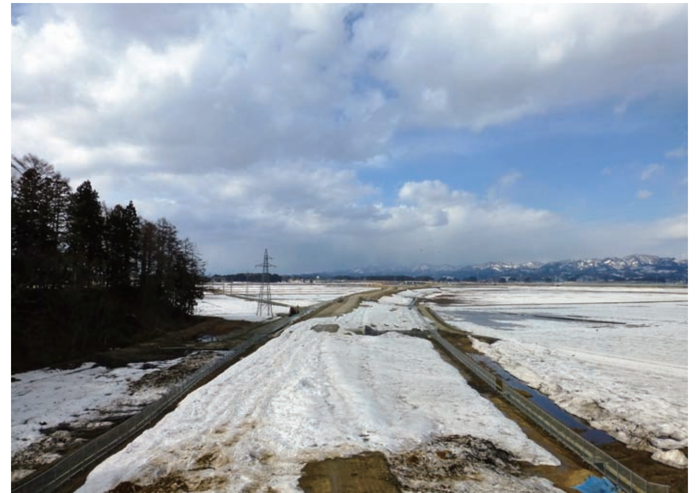
ミッシングリンク（東北中央道、尾花沢市付近）
